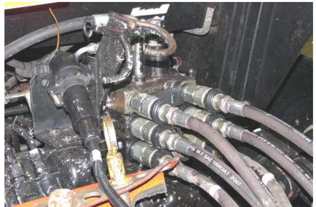
Проверка гидравлических шлангов
