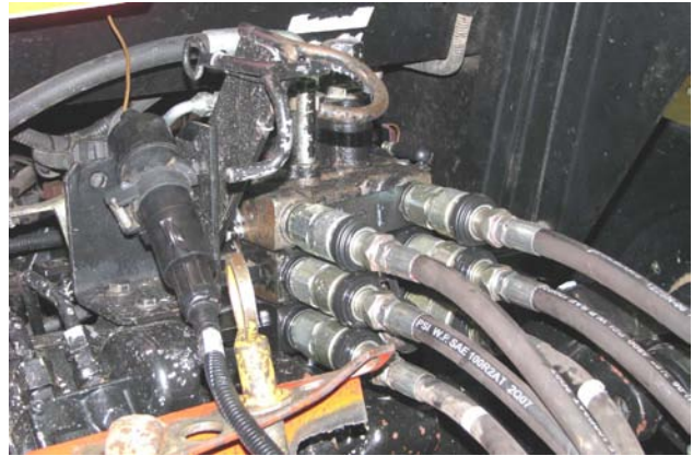
Отсоединение гидравлических шлангов и электрических проводов
