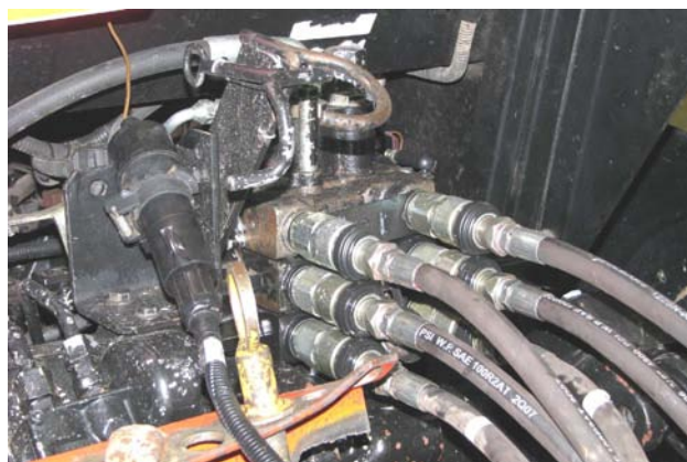
Отсоединение гидравлических шлангов и электрических проводов 108008
