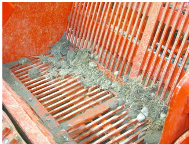
Очистка агрегата от мусора и камней
