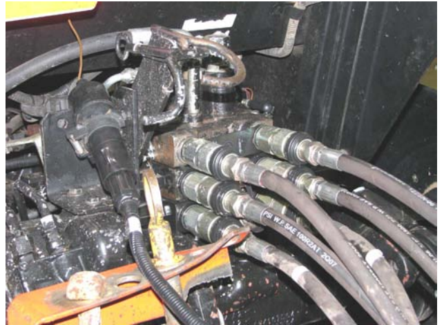
Rebranchez les tuyaux hydrauliques
