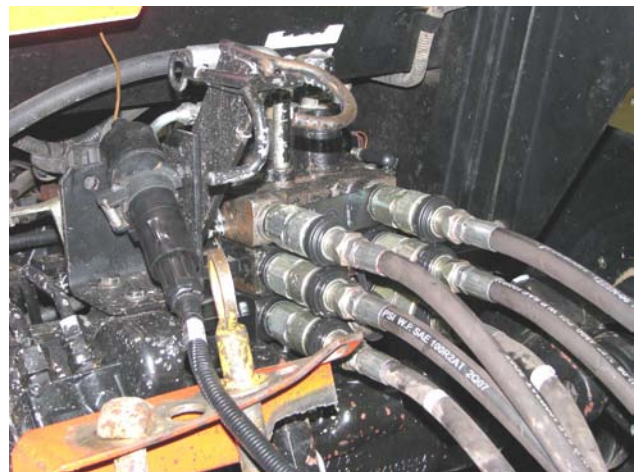
Ricollegare l'impianto idraulico 108008
