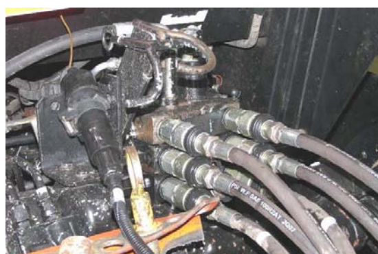
Отсоединение гидравлических шлангов и электрических проводов 108008-1
